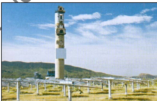
Aprovechamiento solar en una central solar térmica de torre central
